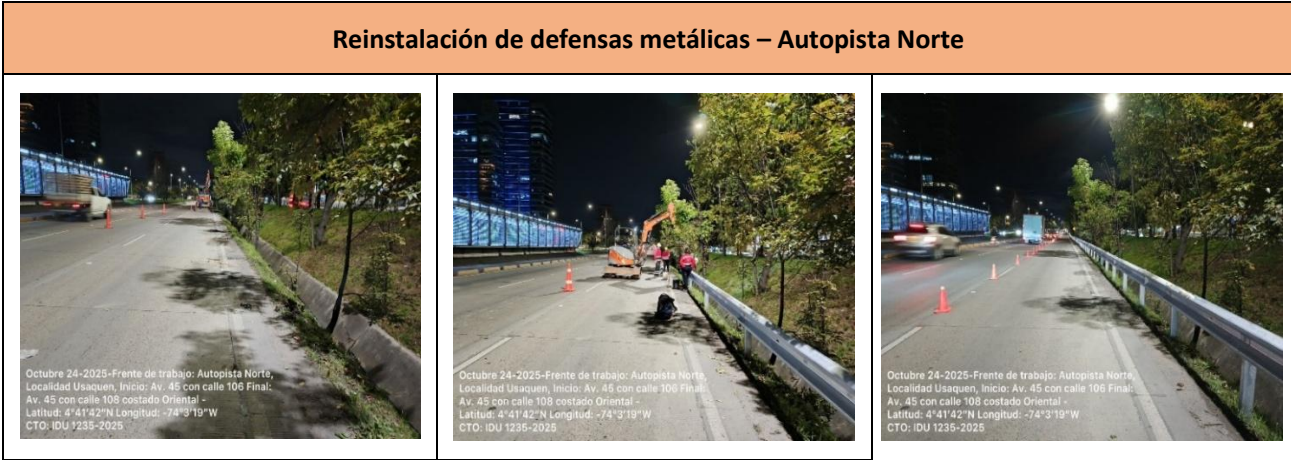
Ilustración 38: Registro fotográfico actividades proyecto Vallados IDU - Defensas
