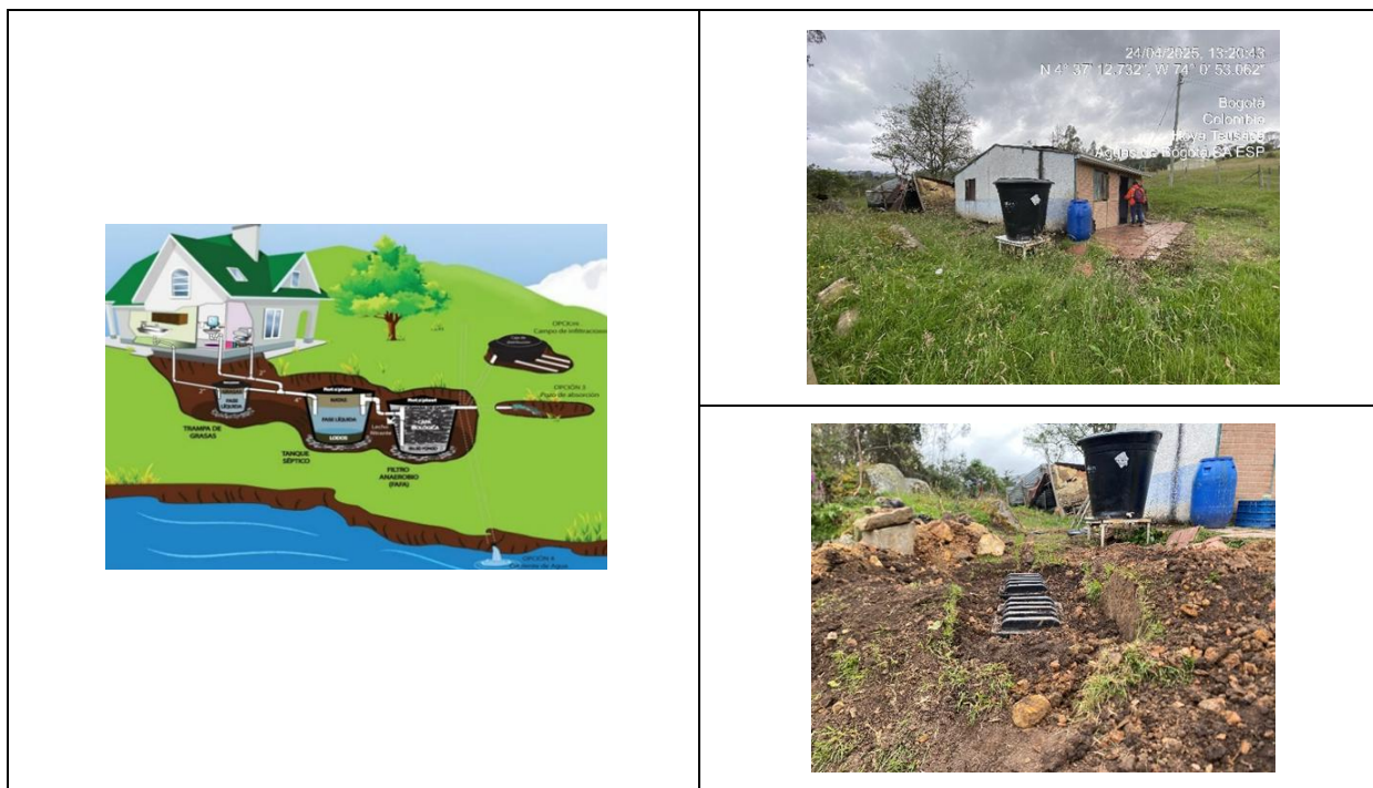
Ilustración 31: Registro fotográfico Instalación SITAR proyecto Chapinero
