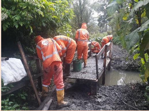
Mantenimiento de cerramientos
