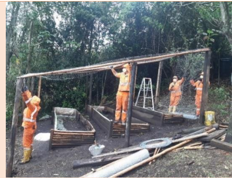
Instalación de mobiliario en madera
