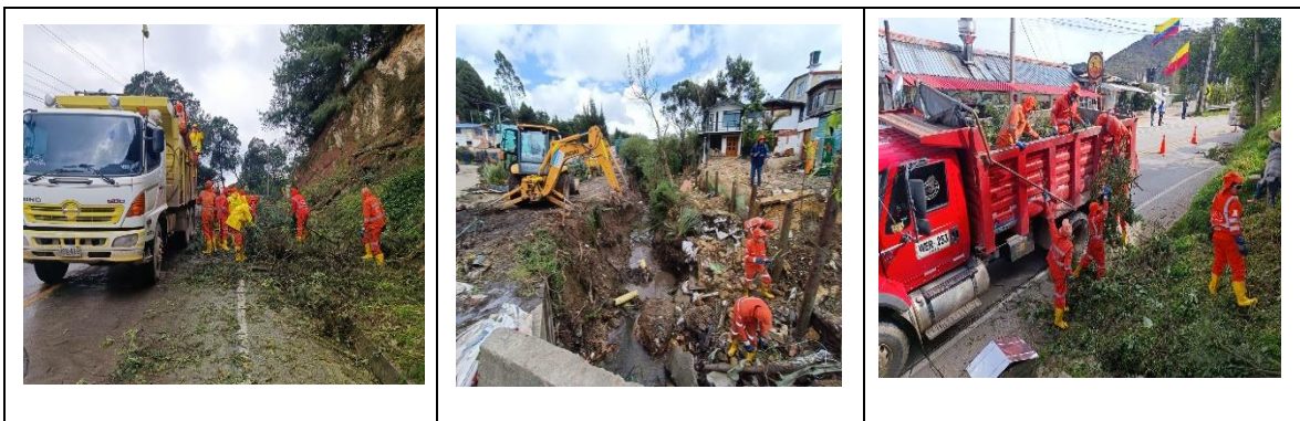
Ilustración 11: Intervención km 1 al 6 de la vía Bogotá – La Calera
